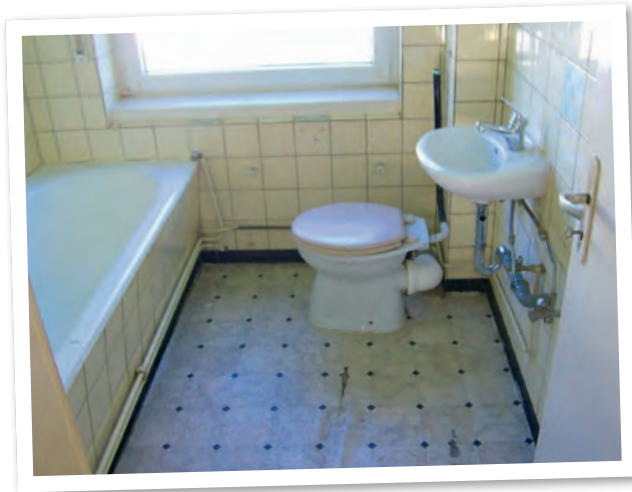
Blick in ein Bad vor der Sanierung
