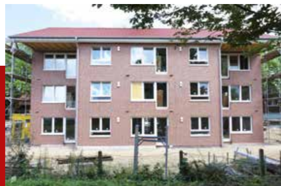
Fertige Bauabschnitte: Darbrookstraße 12 und 14
